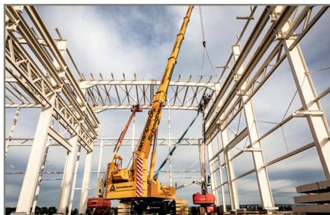
Fertigteilmontage, für Stahlbaumontagen und in der Windkraft vorgesehen. Seinen ersten Einsatz hatte der LTR 1100 auch gleich bei Liebherr in Ehingen. Im Auftrag des
